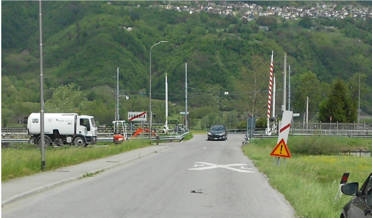
Passaggio a livello al km 24+270 da sopprimere
